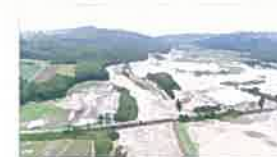
H28.8大雨被害(堤防決壊) (南富良野町)
