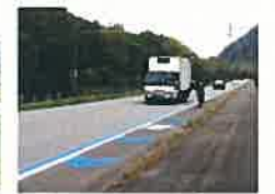
車道への通行位置明示
