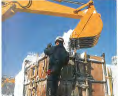
木枠を組み、パワーショベルで雪をつめて土台を作る A base is made by filling a wooden frame with snow
