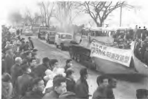
昭和35年、北海道冬期道路交通確保10周年記念式の機械パレードで行進する戦車改造型除雪車
